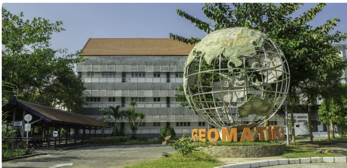
Gedung Departemen Teknik Geomatika ITS.
